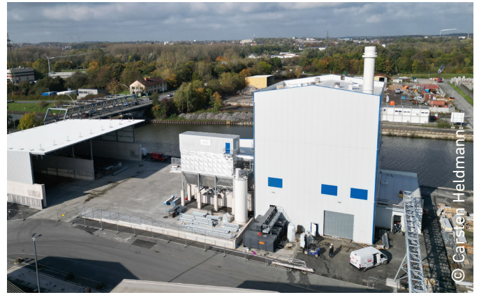
Biomasseheizwerk im Bau.
