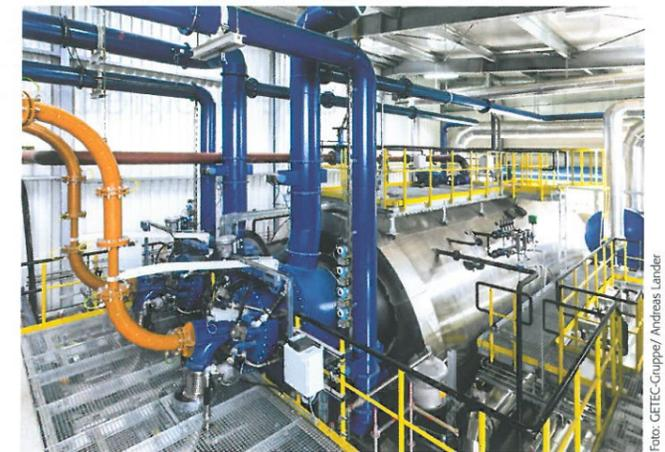
Teil einer Kraft-Wärme-Kopplungsanlage bei dem Chemieunternehmen Radici Chimica Deutschland GmbH im sachsen-anhaltischen Elsteraue. Die KWK-Anlage bietet dem Unternehmen die Möglichkeit, neben Strom für die Industrie auch Prozesswärme zu erzeugen.
